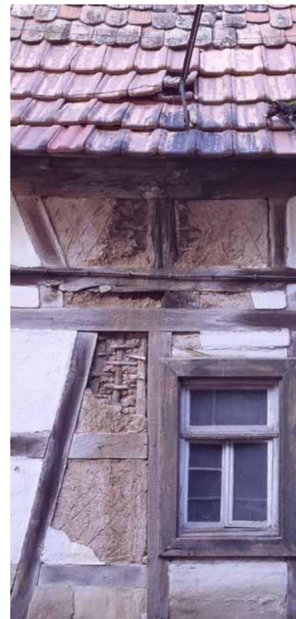
Fehlen Tropfkanten an Gesimsen, Mauervorsprüngen und Fensterbänken, ist die Fassade partiell dem ablaufenden Wasser schutzlos ausgesetzt.
