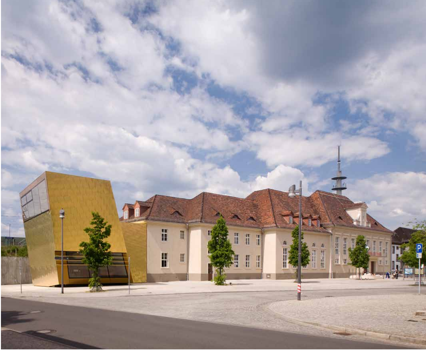
Das ehemalige Luckenwalder Bahnhofsbau- Gebäude mit dem 2008 fertiggestellten Zubau dient heute als Bibliothek. (Planung: ff-Architekten)
