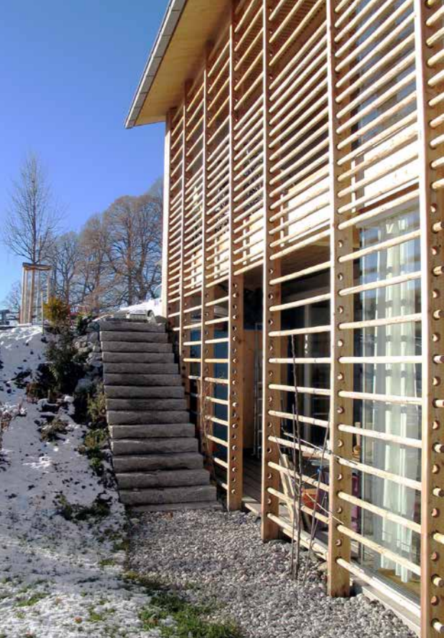
Die Südhanglage der Siedlung am Schmiedberg ermöglicht die passive Solarenergienutzung. Die zweigeschossigen Gebäude stehen alle ohne Abstand zur Straße und sind Richtung Norden eingegraben. Nach historischem Vorbild wurden zwischen den Parzellen drei Meter breite, grasbewachsene Fußwege freigelassen.
