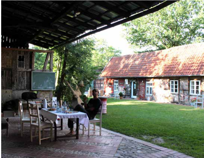
In den Sommermonaten wird der Schauer – der überdachte Vorbereich der Scheune – besonders intensiv genutzt.
