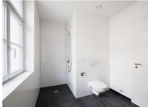
**84** *Barrierefreier Badumbau; Stütz- und Haltesysteme werden bei Bedarf individuell angepasst; Hohenzollernhöfe, Ludwigshafen*
