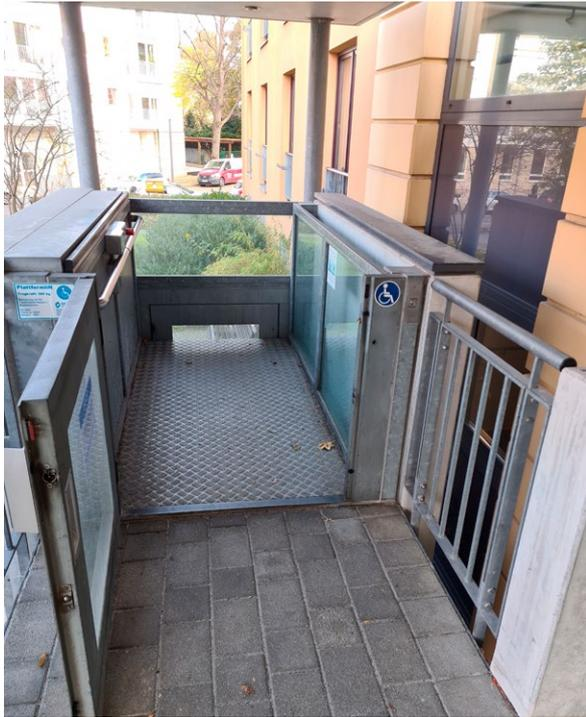
**20** Hebeplattformlift als Durchlader konzipiert. Bei Mehrfamilienhäusern sollte zur sicheren Zugänglichkeit vorzugsweise ein klassischer Aufzug eingebaut werden.
