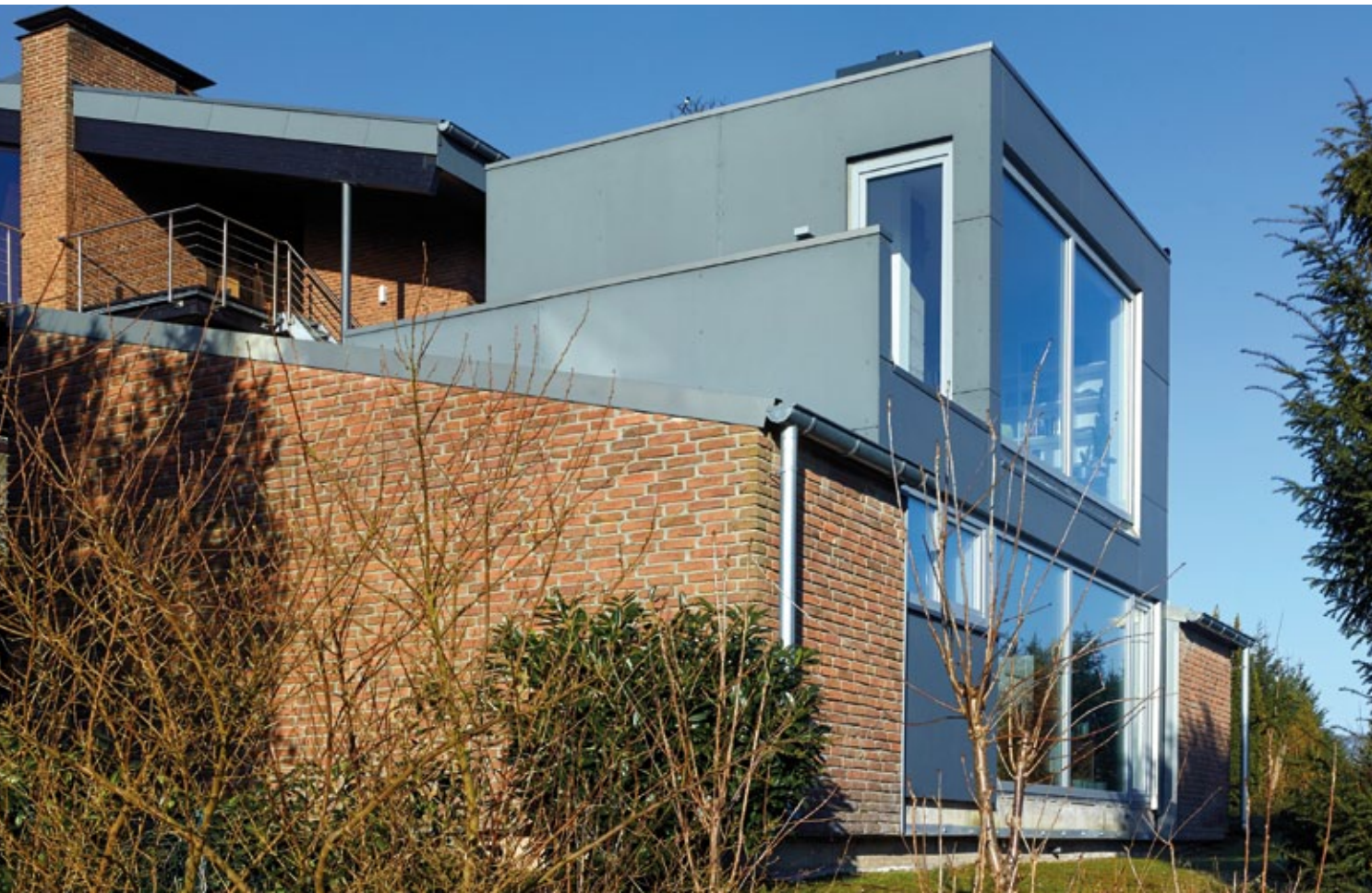
Umbau Schwimmbad zu Wohnhaus | Architekt Johannes Pflüger, Daun | © Fotostudio Nieder, Dominik Scheid, Daun
