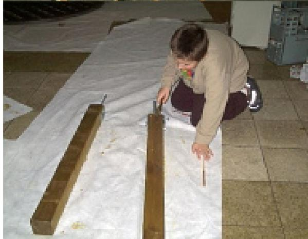
Eine Herausforderung war das Durchsägen der Holzpfosten und das Anschrauben der Stahlfüße zum Einbetonieren des Holzzaunelementes. Beim Anschrauben des Zaunelementes auf die Holzpfosten war der Hausmeister sowohl mit Werkzeug, als auch beim Arbeiten mit der Bohrmaschine behilflich. Da sich die Grundschulkindern vielfach der Verletzungsgefahren beim Arbeiten mit den unterschiedlichen
