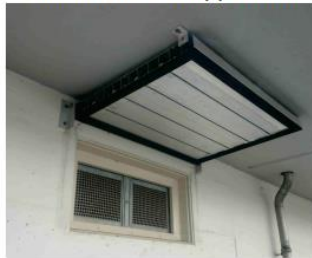
druckdichtes Klappschott
