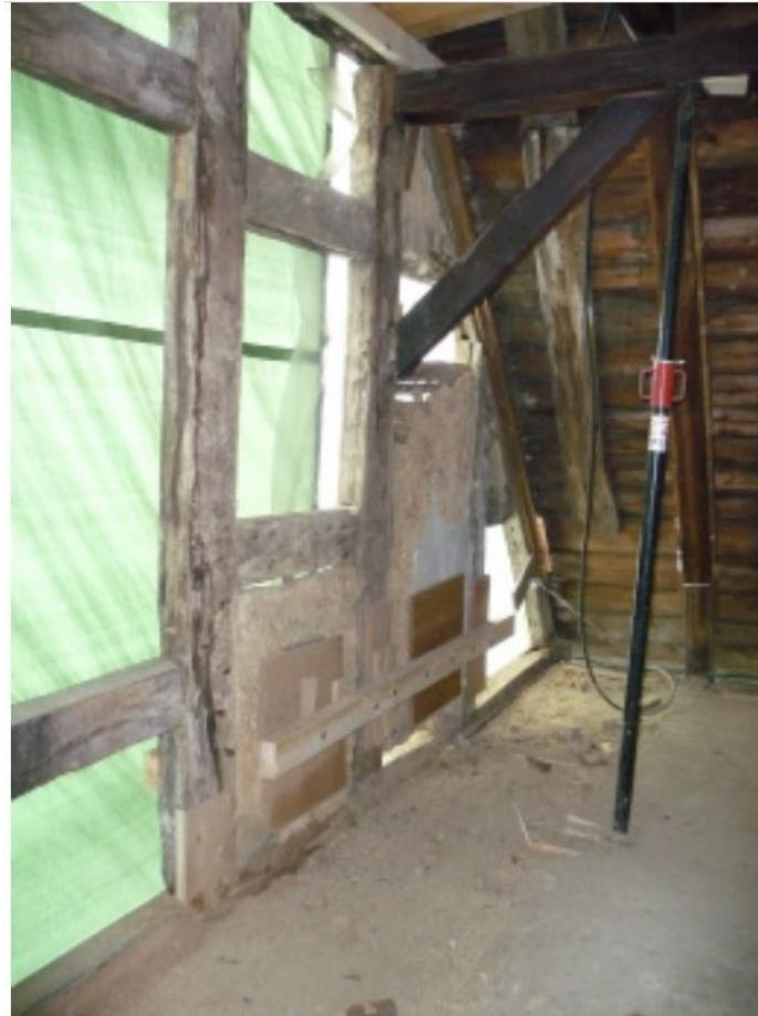
Sicherung zur Reparatur
