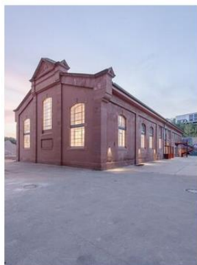
"Altes Kesselhaus" PFAFF-QUARTIER | Bayer & Strobel Architekten BDA, Kaiserslautern Foto: Peter Stobel, Kaiserslautern
