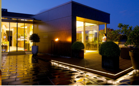
Erweiterung im Weingut Ralph Anton in Kirrweiler
