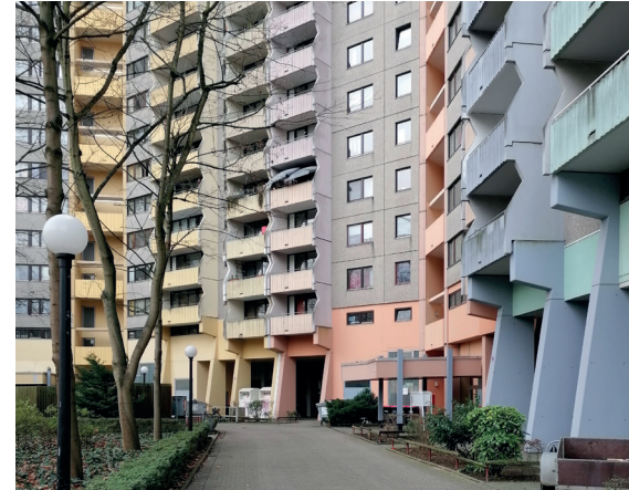
Elsa-Brändström-Straße © DIE BETONISTEN, Mainz
