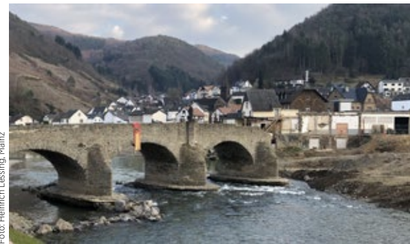
Die Nepomukbrücke in Rech ist seit dem Jahr 1981 als Kulturdenkmal geschützt.
