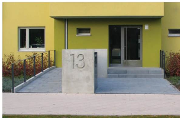
29 – 31 Kombinierte Rampen- und Treppenanlagen sichern die stufenlose Erreichbarkeit der Eingänge nach dem Umbau; Ostseevierviertel Parkseite, WVG Greifswald
