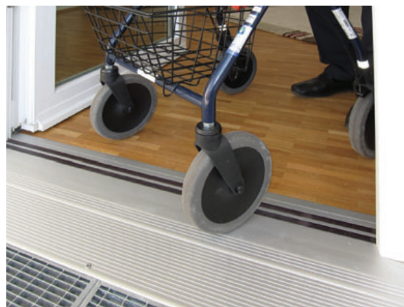
110 Niveaugleiche Magnet-Türdichtungen leiten anfallendes Wasser über die Konstruktion nach außen ab.
