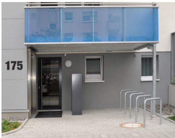
51 – 52 Im Zuge eines Aufzug- und Balkonanbaus wurde auch der Eingangsbereich windgeschützt und überdacht gestaltet. Die stufenlose Erreichbarkeit wird über die Balkone gewährleistet. Römerstraße, Leonberg
