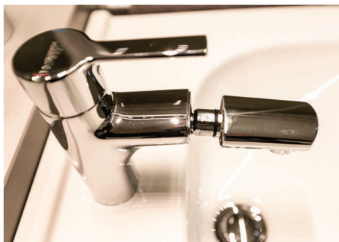
145 Einhebelarmaturen mit ausziehbarer, integrierter Schlauchbrause bieten bei Bedarf zusätzlichen Komfort.
