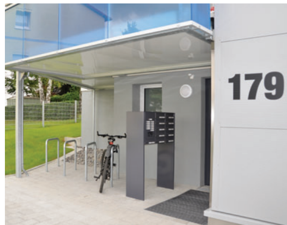
51 – 52 Im Zuge eines Aufzug- und Balkonanbaus wurde auch der Eingangsbereich windgeschützt und überdacht gestaltet. Die stufenlose Erreichbarkeit wird über die Balkone gewährleistet. Römerstraße, Leonberg
