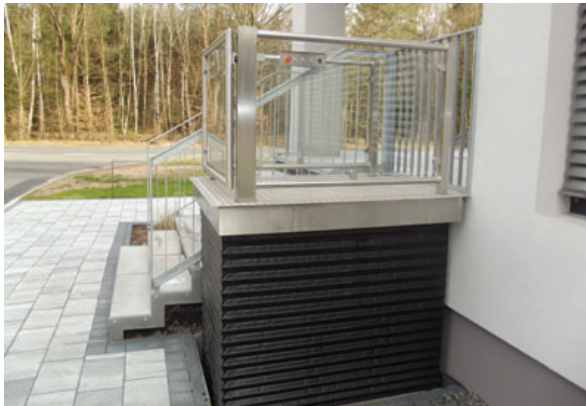
36 Hebeplattformlift als Durchlader konzipiert. Aufgrund der gesicherten Zugänglichkeit sollte bei größeren Mehrfamilienhäusern vorzugsweise ein Aufzug eingebaut werden; Ausserhalb, Babenhausen
