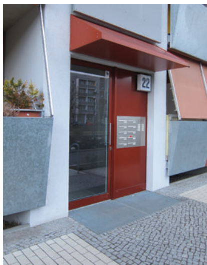
26 – 27 Belagswechsel zwischen Kleinstein-, Betonsteinpflaster und Gitterrosten bieten taktile und visuelle Orientierungsangebote; Gartenstadt Drewitz, ProPotsdam
