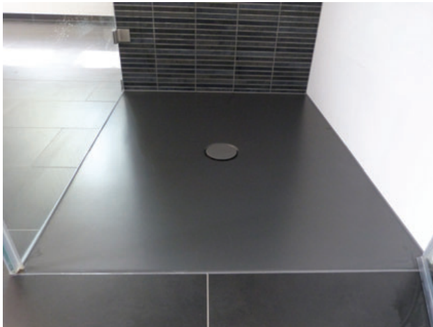
141 – 142 Duschplatzgestaltung mit vorgefertigten Duschelementen bzw. Entwässerung über alternative Wandeinläufe
