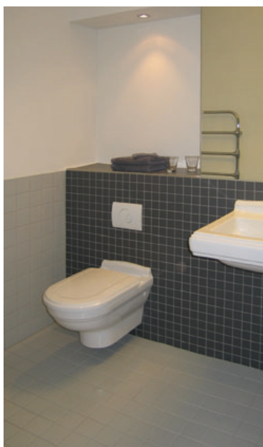
146 Heizkörper als Handtuchhalter und Thermostat in Greifhöhe; Altenpflege Mühlthal
