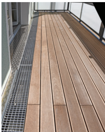
107 – 108 Vorgestellte Balkone mit Aufzugsanlage an einem denkmalgeschützten Gebäude; Hohenzollernhöfe, Ludwigshafen
