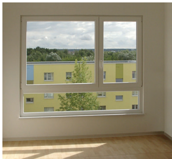
100 Erneuerung Fenster mit fest verglaster, absturzsicherer Brüstung und kleinem Gangflügel; Ostseevierviertel Parkseite, WVG Greifswald
