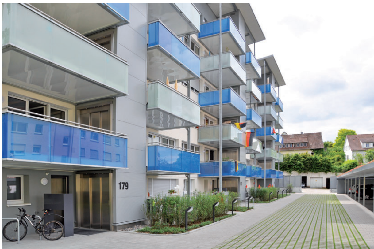
83 Der Anbau einer kombinierten Balkon-Aufzugsanlage ermöglicht den barrierefreien Zugang zu Balkonen und Wohnungen in allen Stockwerken; Römerstraße, Leonberg
