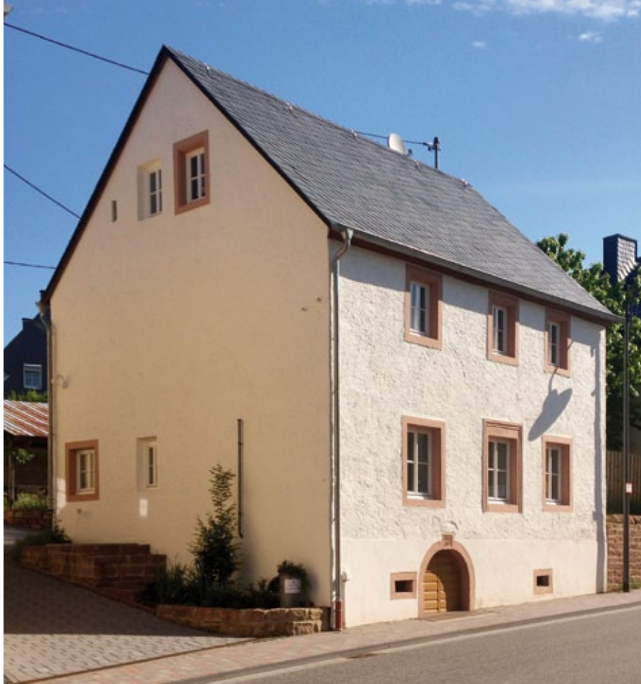
Energetische Sanierung und Umbau, Dreis Architekt Daniel Spreier, Spreier Trenner Architekten, Dreis | © Daniel Spreier, Dreis
