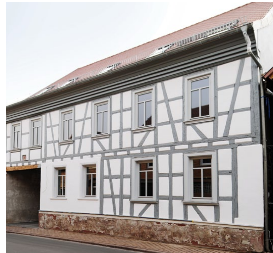
Umbau Zollhaus, Nackenheim | Architekt Holger Ries Ries + Ries Architekten Ingenieure GbR, Budenheim © Carsten Costard, Budenheim
